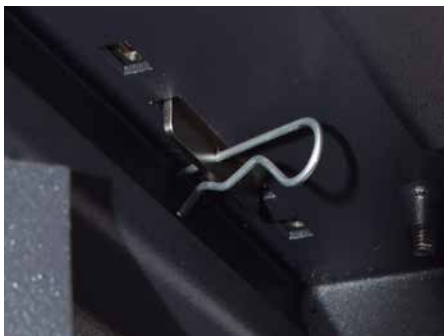
7. Von unten die Glashaube mit den 4 Glas-halteklammern, wie abgebildet, sichern.
