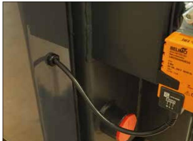
7. Wir nehmen die **runde Sibral-Dichtung** (Bestandteil des Sets, Pos. 18) und kleben sie mit Silikondichtstoff oder einem anderen Kleber auf die Unterseite der Steuerklappe, die vom Zugregler FR 124 gesteuert wird. Die **Anschlagschraube** an der Klappe sollte auf einem minimalen Schließweg von 4 – 8 mm eingestellt bleiben.
