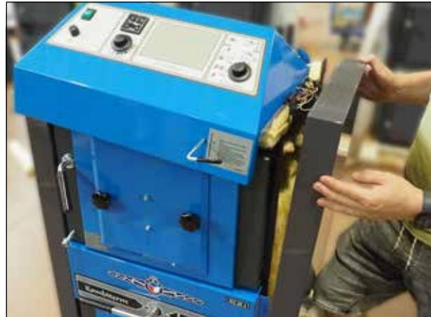
5. Für die 6-poligen und 5-poligen Anschlüsse brechen wir eine rechteckige Öffnung in der Seitenhaube des Kessels aus. In der Öffnung für den 6-poligen Stecker befestigen wir die Tülle. An der Öffnung für den 5-poligen Stecker bringen wir eine Steckerreduzierung für den 2-poligen Stecker (R3 und R4) und den TK-Sensor an.
