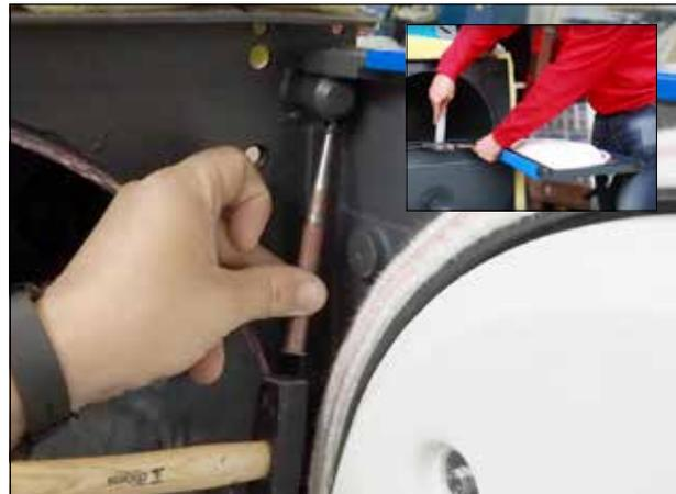
3. Wir montieren die komplette Tür mit der Öffnung für den Brenner in umgekehrter Reihenfolge und befestigen sie mit neuen Stiften. Den unteren Teil (im Hohlraum) hacken wir mit einem Locher oder einem Flachmeißel ein, damit sich die Stifte nicht von selbst lösen können.
