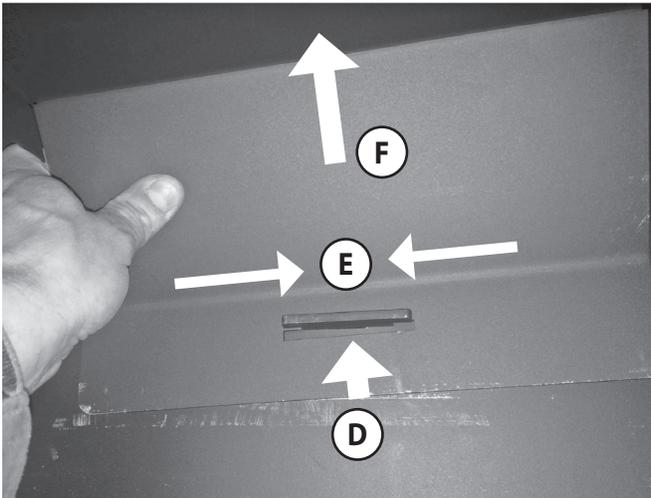
Die **4. Heizgasumlenkung** ist mit einer Bajonethalterung an der Decke im Inneren des Gerätekorpus befestigt.
